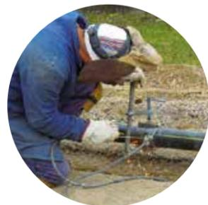
**CELULOSICO MMA** Esta función está diseñada para el uso de electrodo celulósico, asegura una estabilidad excepcional y una óptima penetración. Es ideal para la soldadura en todas posiciones.
