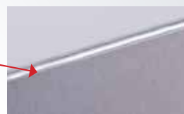
Détail du soudage d'arête. On remarque le niveau de finition et la précision du soudage obtenus
