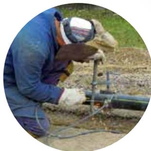
Die hohe Dynamik der Abgabe des Schweißstroms der Funktion zum Schweißen mit celluloseumhüllten Elektroden gestattet die verbesserte Kontrolle der Abschmelzung und der Einbrandtiefe. Ideal für den Einsatz in der Hydraulik, bei Pipelines und in der petrochemischen Industrie. Hot Start kann je nach Bedarf eingestellt werden, zum Erhöhen des Anfangsstroms für eine optimierte Zündung. Arc Force ist auch einstellbar und verbessert den Werkstoffübergang.
